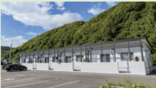
町営住宅の清川団地 平成27・28年度に各1棟4戸、平成29年度に1棟8戸を建設。
