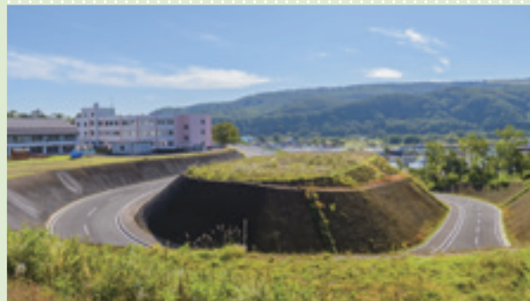
町道高校通線 勾配緩和と車道拡幅の工事が完了。国道・道道の整備も関係機関に要請中。
