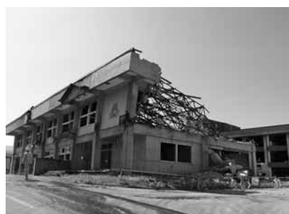
旧小学校校舎解体 (6月11日撮影)
