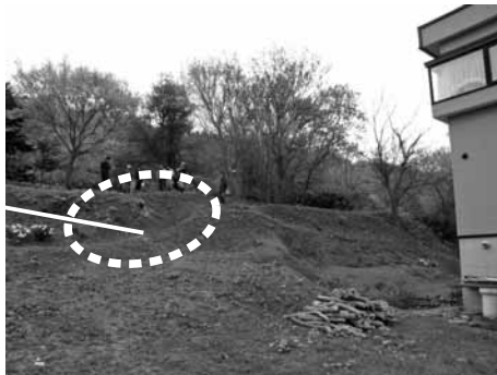
久保田一美宅裏（工事前）
