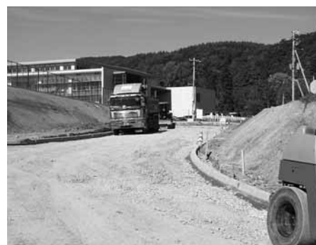
町道小学校通線。左側に歩道を新設 (10月4日撮影)
