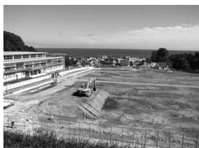
旧校舎跡地に多目的運動広場 (10月4日撮影)
