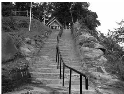
厳島神社地先の階段。 もともとあった階段を平に整備。 （10月10日撮影）
