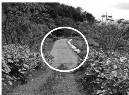
改修後（堤防が嵩上げ）
