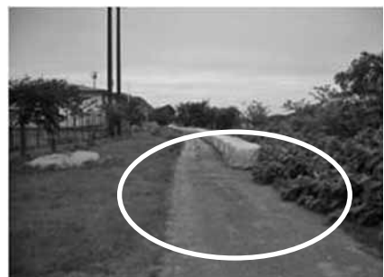
改修前の越流箇所
