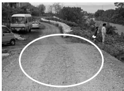
改修後（堤防が嵩上げ）
