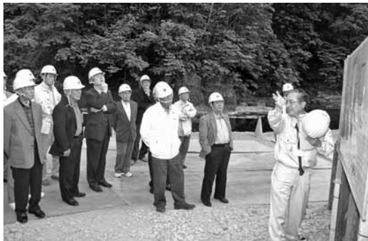
廻り淵橋の工事現場で小樽建設管理部余市出張所長より工事の進捗状況などの説明を受ける
