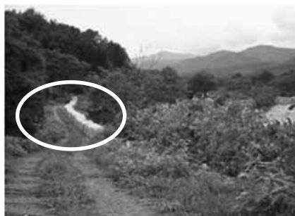
改修前の越流箇所
