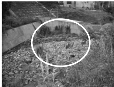
改修前の築堤損傷箇所
