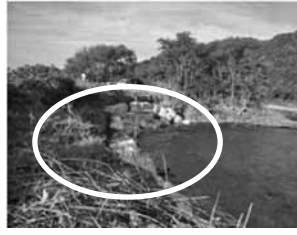
改修前の築堤損傷箇所
