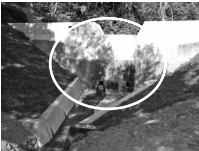
改修後 治山ダム
