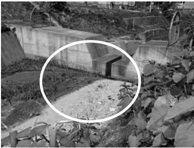
改修後（土砂が取り除かれる）
