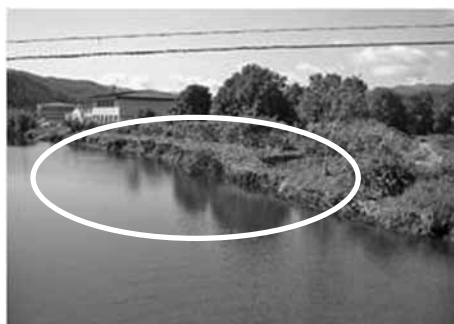
改修前の河岸決壊箇所
