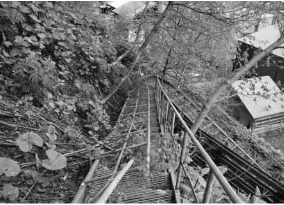
草木が生い茂り、手すりも倒壊
