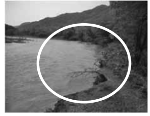
改修前の築堤損傷箇所
