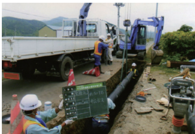
（老朽配水管布設替）
