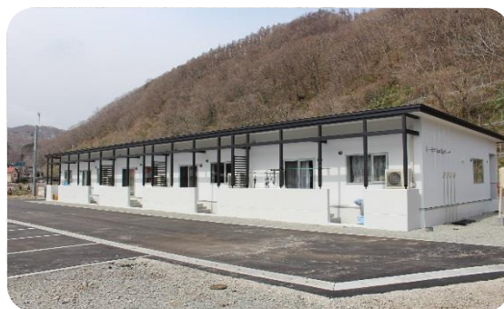
清川団地B棟（平成28年度建設）
