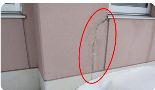
中学校亀裂箇所の一例
