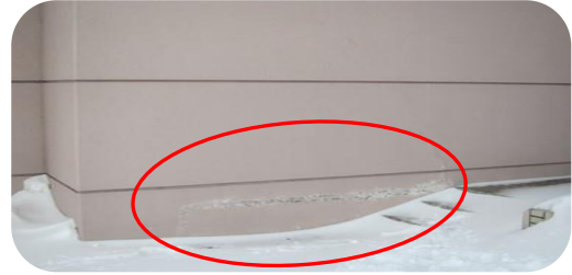
中学校体育館外壁亀裂の一部
