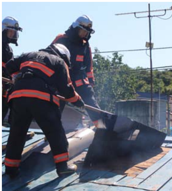
屋根に穴をあけ排煙するようす
