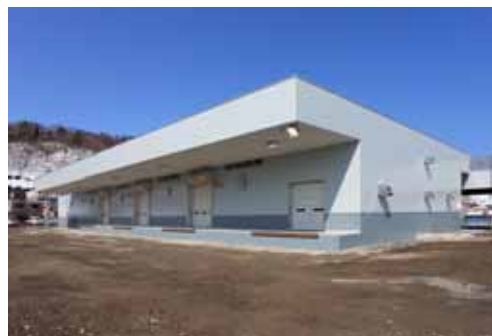
床が高くなっており外から車の乗り入れができない構造
