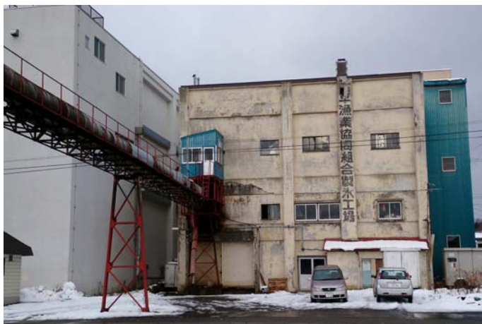
昭和39年に建設された現在の製氷・貯氷施設
