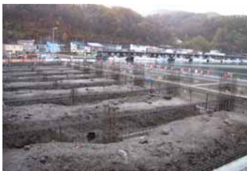
基礎の鉄筋が組み立てられる =11月8日撮影
