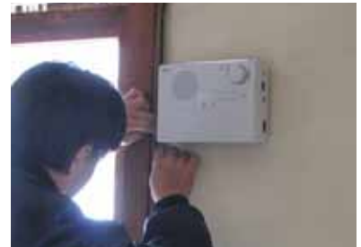
戸別受信機を設置 =11月13日撮影
