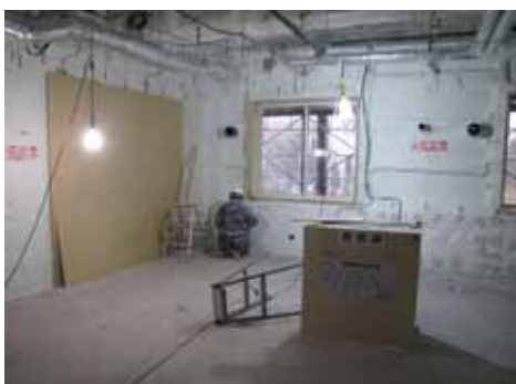
元教室だった部分が仕切られ、部屋の壁が整う =11月8日撮影
