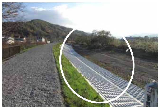
堤防をきれいに整備。 撮影日：10月31日
