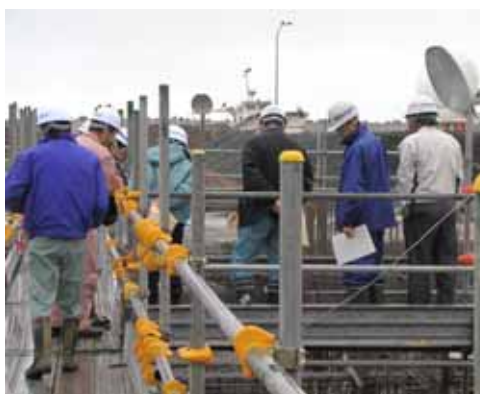
事故防止の措置がとられているか、確認する参加者＝荷さばき施設新設工事現場
