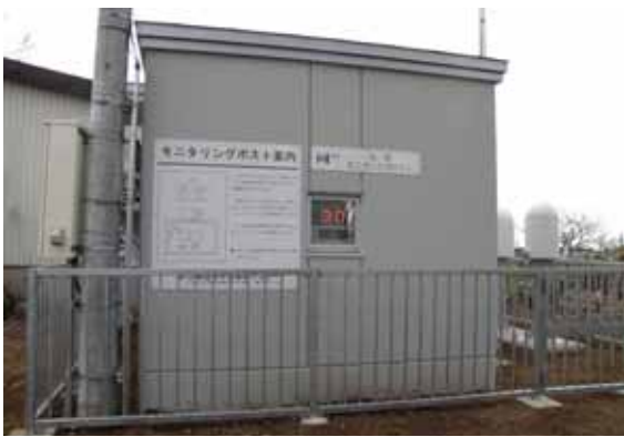
文化会館前広場に設置された モニタリングポスト
