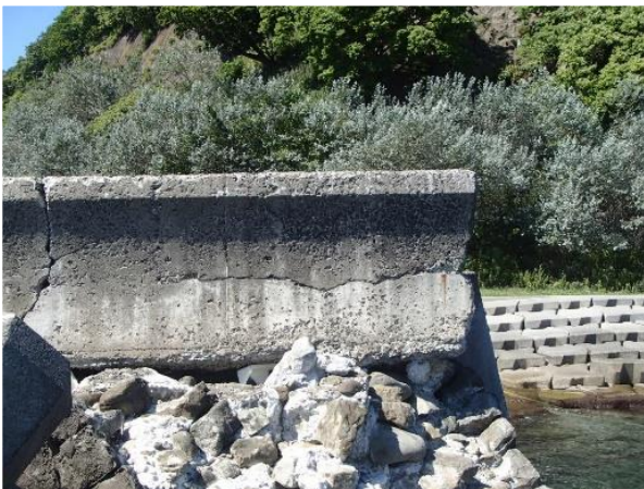
▲既存海岸護岸の老朽化状況
