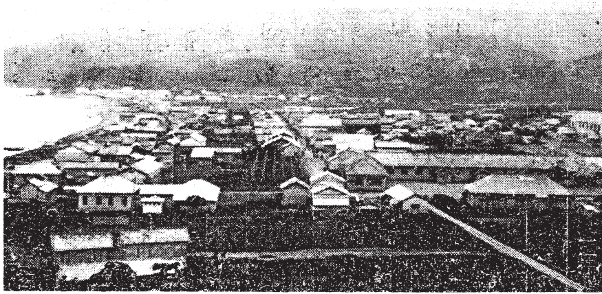
→ 新築の浜中小学校校舎
