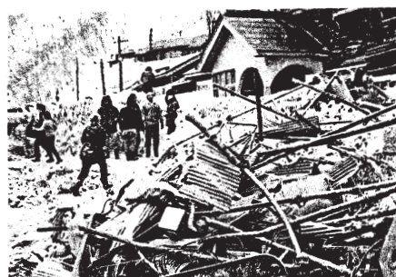
↑ 稲倉石の災害状況
