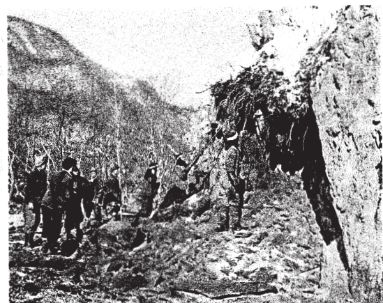
↑崖を切り崩して道路の建設
