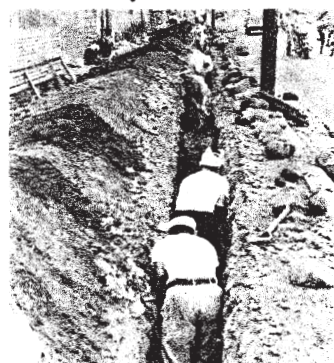
↑ 市街地での水道管設置
