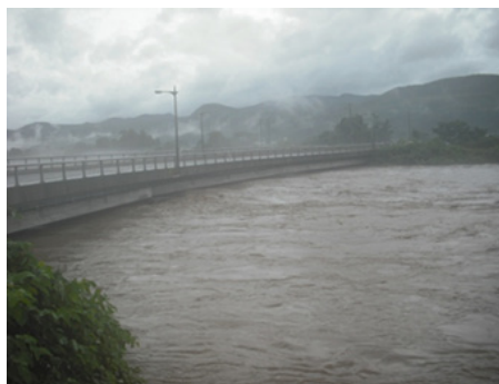
増水している古平川 (H22.7.29)
