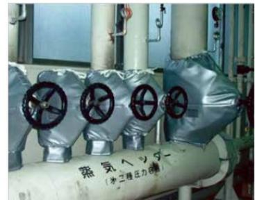
図 蒸気ヘッダ部バルブの保温状況例
