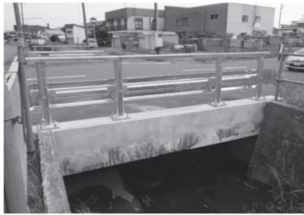
修繕が完了した丸山3号橋
