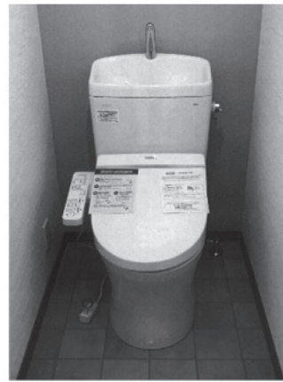
下水道接続工事
