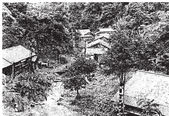
← 国道開通前の出足平町の町並み(ニテタリビラ潮見町)
