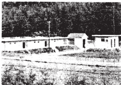
↑ 最初に建設された上水道施設
